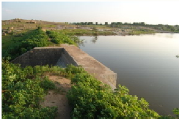
प्लेट-6: पुरानी जल संग्रहण संरचनाओं का लीकेज सुधार
